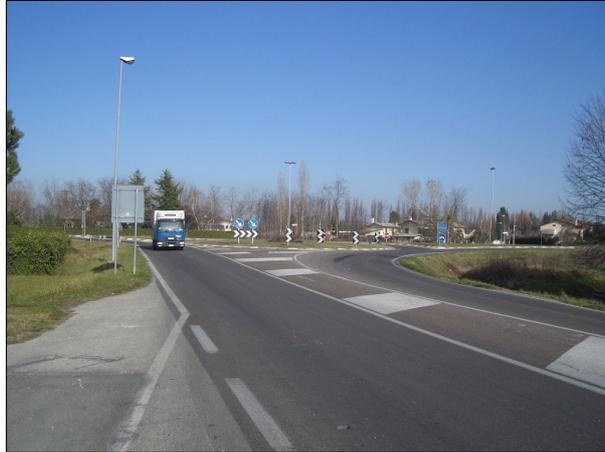
Palo al centro dello svincolo stradale, privo di sbracci ed eventuale mascheramento delle antenne. Gli apparati tecnologici devono essere occultati alla vista tramite l'utilizzo di materiale di riporto oppure tramite siepe arborea.
