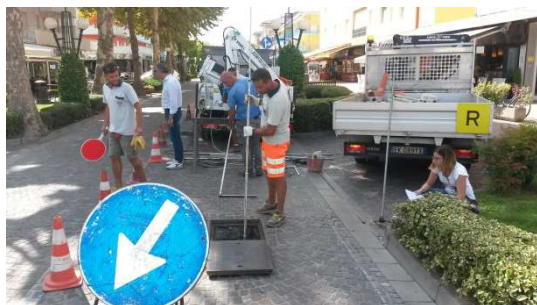
Installazione dei misuratori di livello in Via Aurora e in Via Urano
