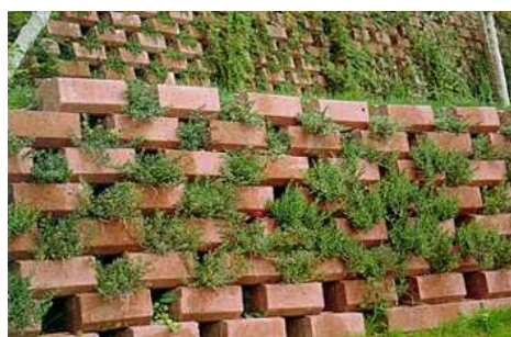
Barriera antirumore in calcestruzzo ed elementi vegetali
